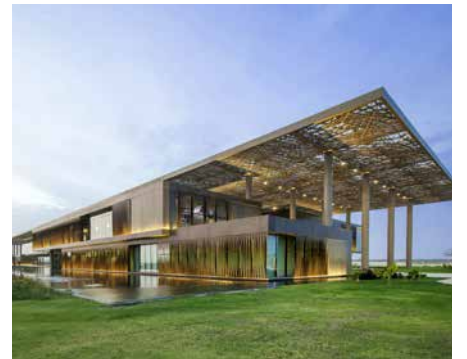
Data Center - Senegal
