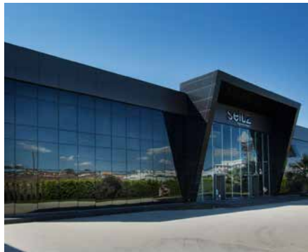
Selüz Kimya Fabrikası - Kocaeli
